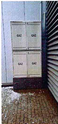
Przyłącze gazu ziemnego do budynku.
